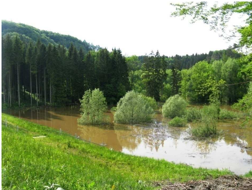
Hochwasser im Becken. Das im Bild oben zu sehende Einlaufwerk ist im Wasser verschwunden
